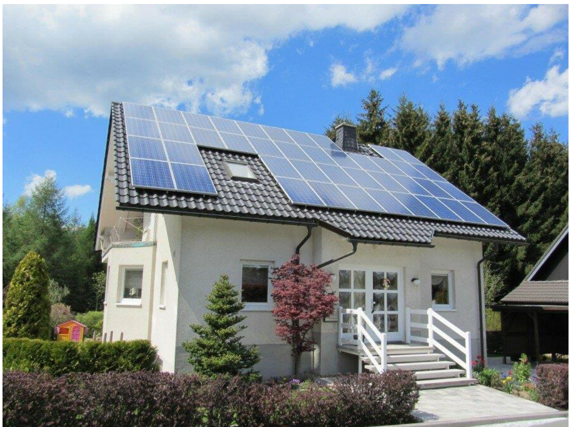
Рисунок 1.3 - Приклад встановлення сонячних панелей на будинках [16]
